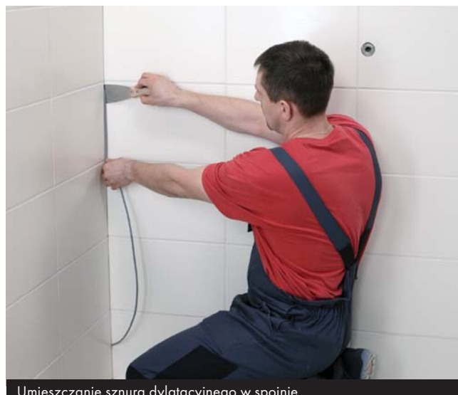
Umieszczanie sznura dylatacyjnego w spoinie
