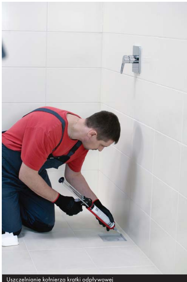
Uszczelnianie kołnierza kratki odpływowej
