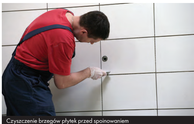
Czyszczenie brzegów płytek przed spoinowaniem
