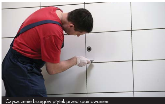
Czyszczenie brzegów płytek przed spoinowaniem
