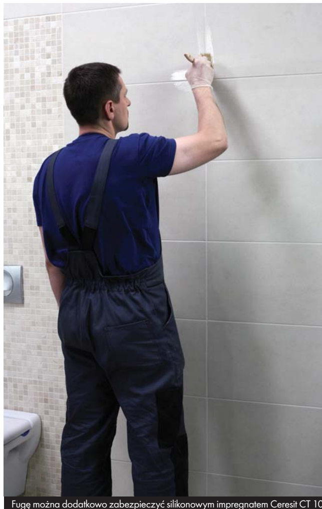
Fugę można dodatkowo zabezpieczyć silikonowym impregnatem Ceresit CT 10
