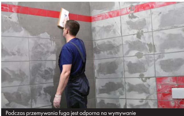
Podczas przemywania fuga jest odporna na wymywanie
